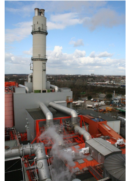
MVA Stellingen Moor (Foto Stadtreinigung HH)
